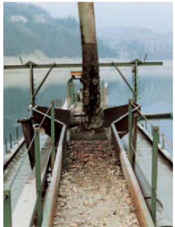
Pompaggio e raccolta ghiaia Pumping and removal of gravel
